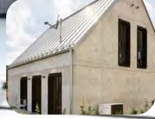
Konventionelle Dämmung vs. monolithische Bauweise mit Infraleichtbeton
